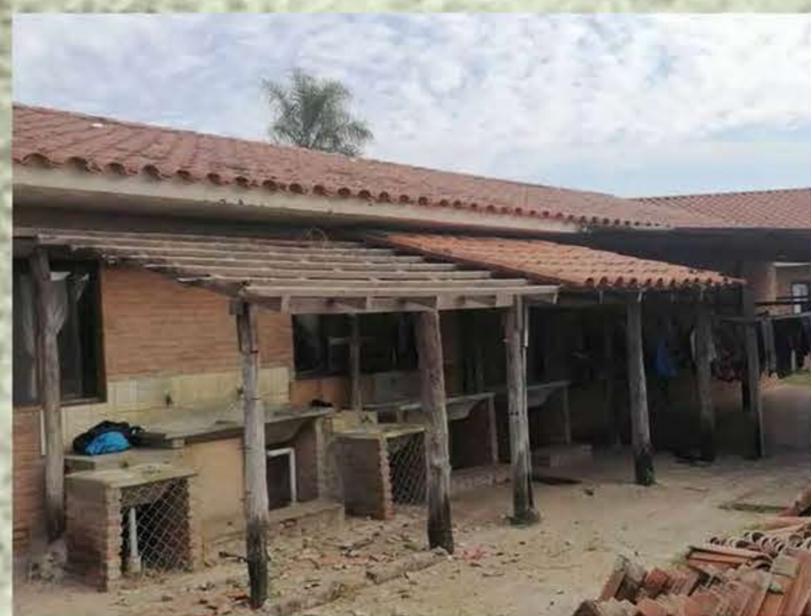
Tetto in riparazione
