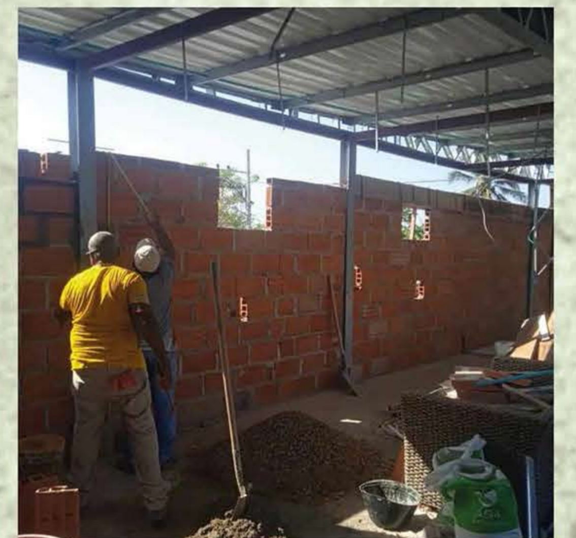
Completamento del rifugio
