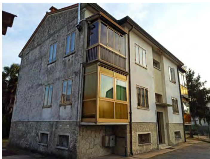
Vista edificio da nord-est
