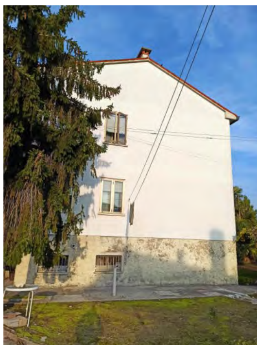
Vista edificio da sud-ovest
