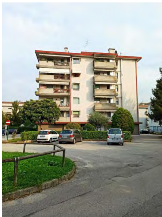
Vista edificio da ovest
