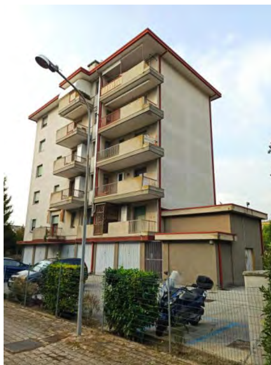
Vista edificio da sud-est
