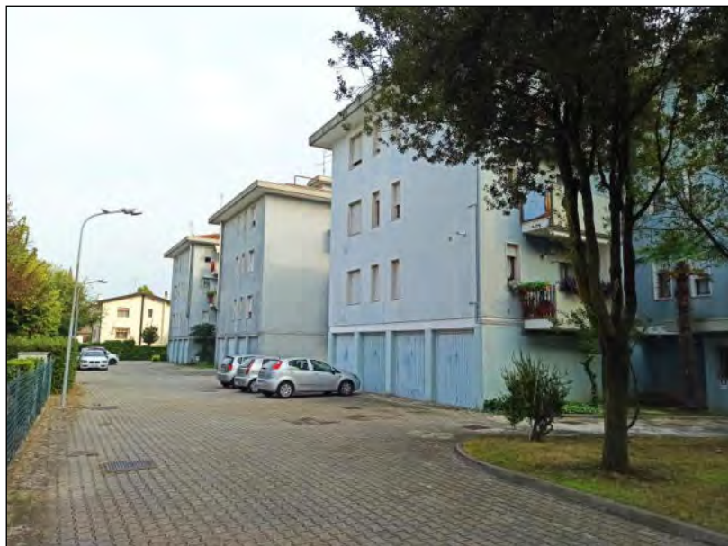
Foto complesso da nord-ovest
