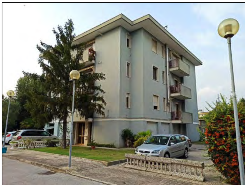
Foto complesso scala A da sud-est
