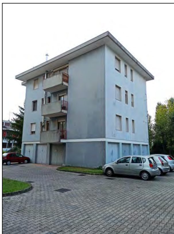
Foto complesso scala A da nord-est
