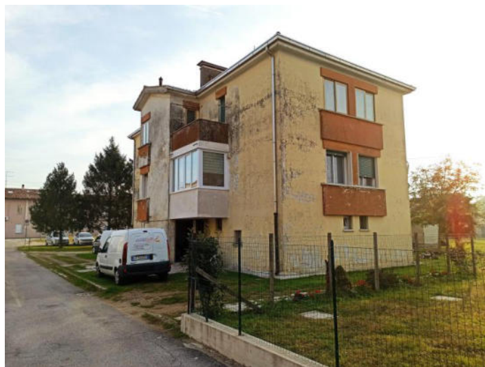
Vista edificio da nord-est
