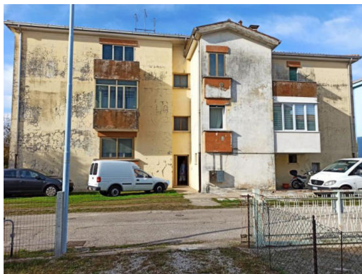
Vista edificio da est
