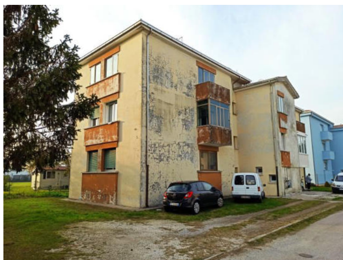
Vista edificio da sud-est
