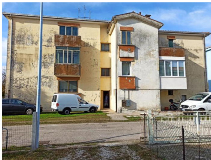
Vista edificio da est
