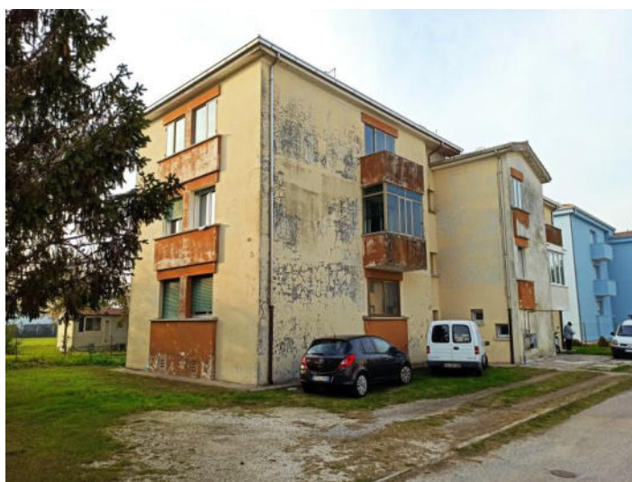
Vista edificio da sud-est
