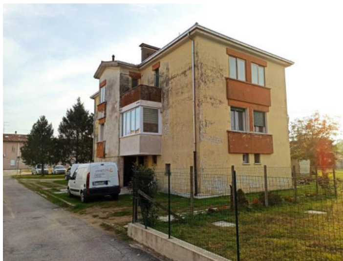
Vista edificio da nord-est
