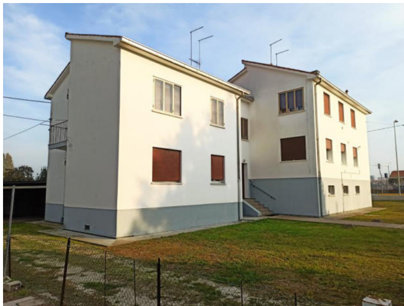
Vista edificio da nord-ovest
