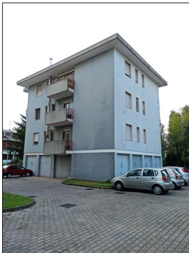
Foto complesso scala A da nord-est
