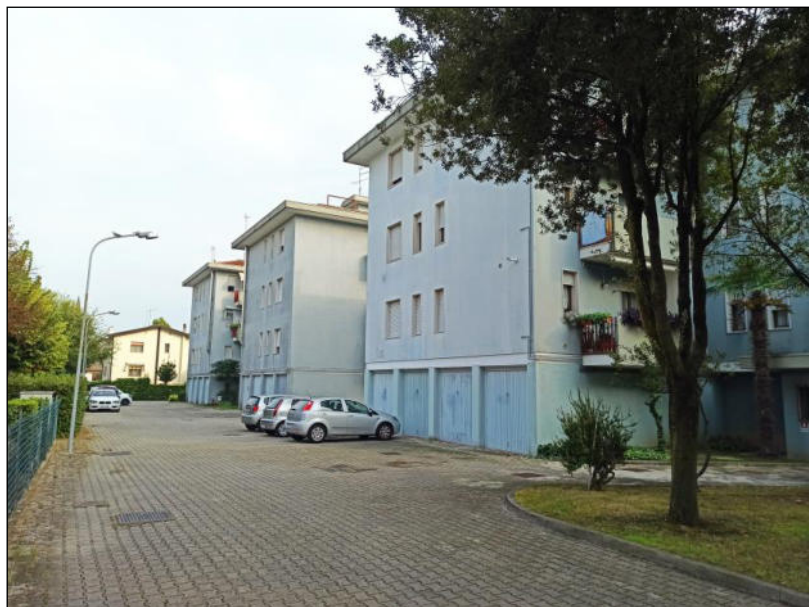
Foto complesso da nord-ovest
