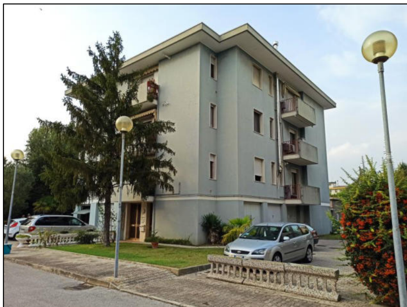
Foto complesso scala A da sud-est
