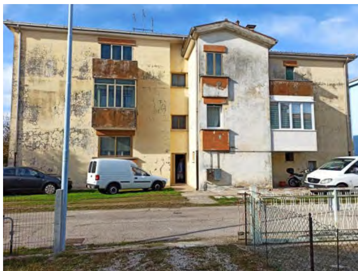
Vista edificio da est
