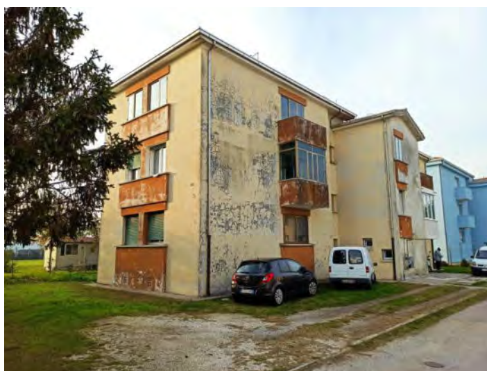
Vista edificio da sud-est
