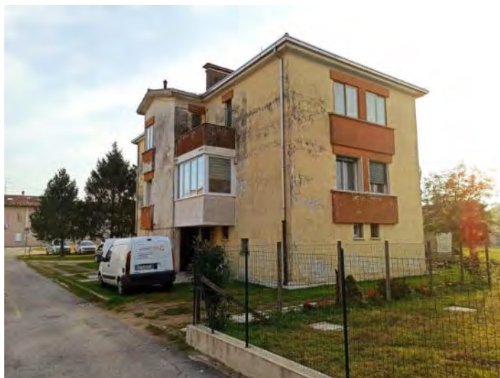
Vista edificio da nord-est
